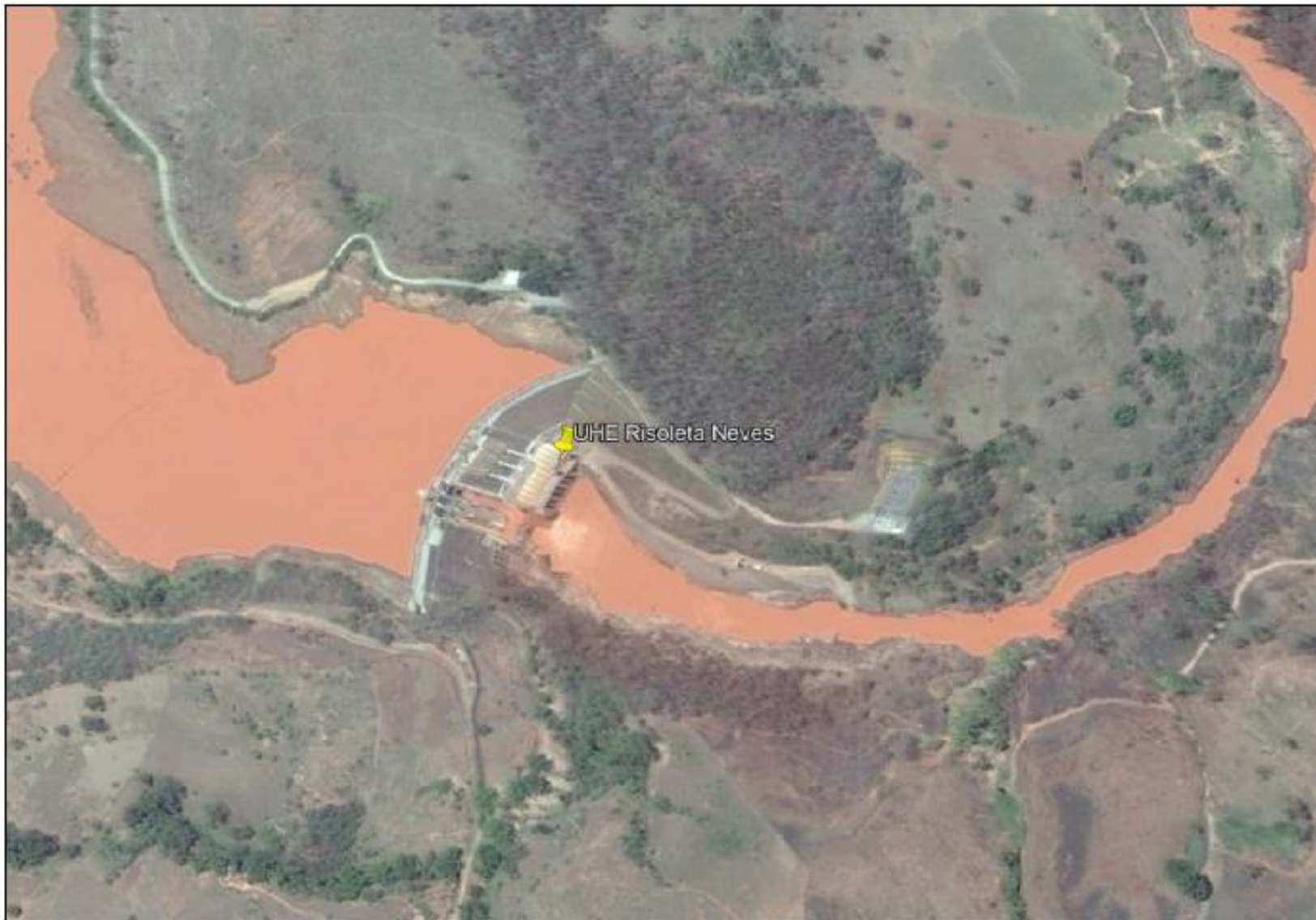
Figura 44: UHE Risoleta Neves 6 dias após o rompimento da barragem de Fundão (foto data: 11/11/2015 – Fonte: Google Earth).
